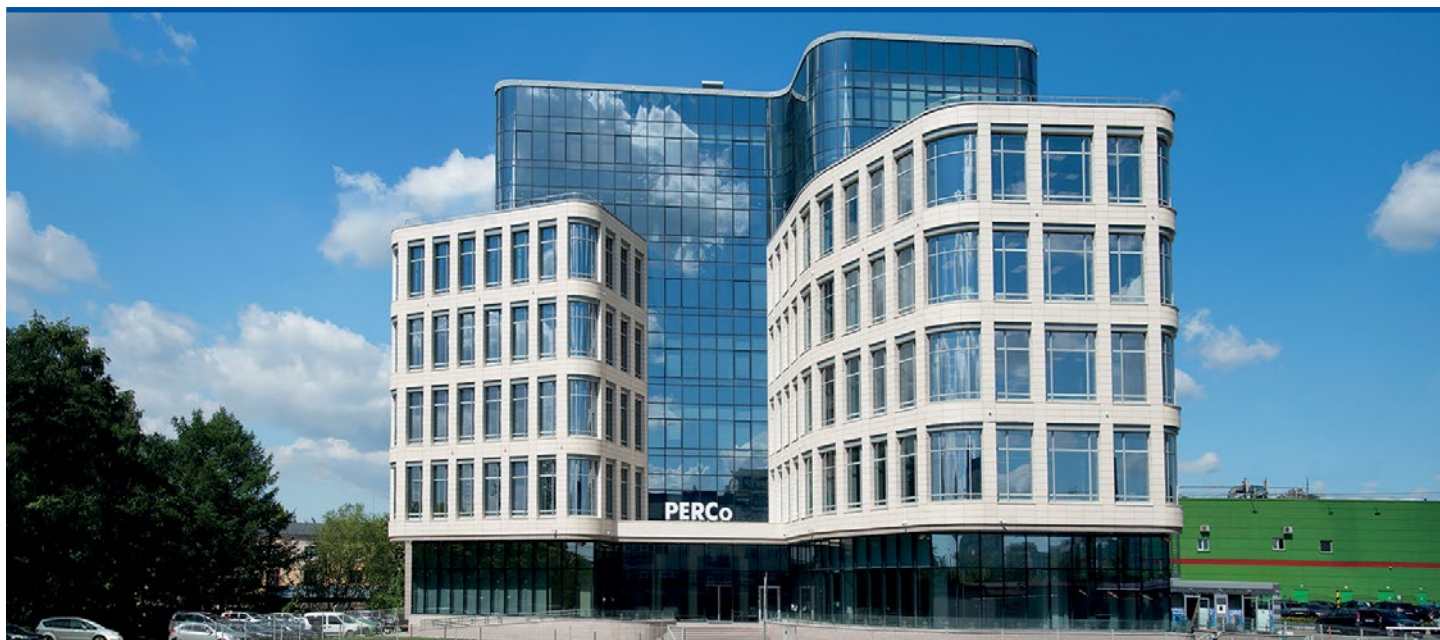
Главный офис PERCo
