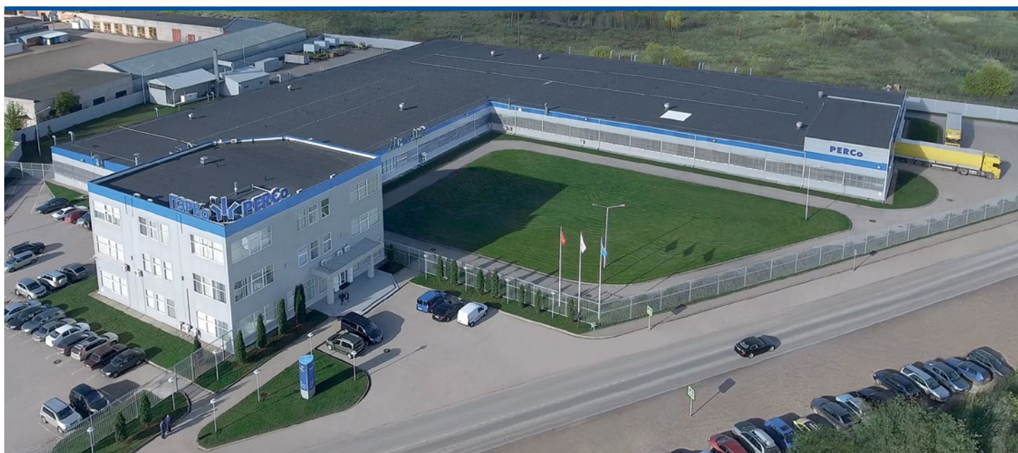
Завод в Пскове
